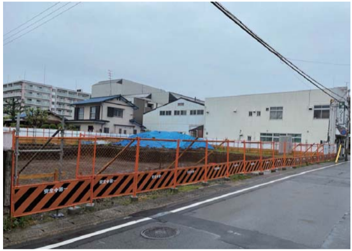
山科区柳辻西浦町の建設予定地
